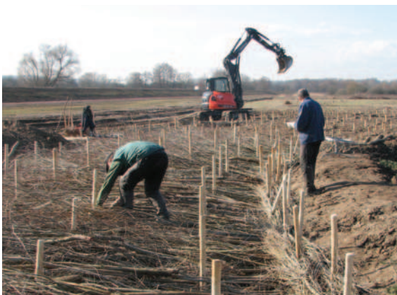
Abb. 4.7: Auslegen der Weidenruten auf einer Böschung
