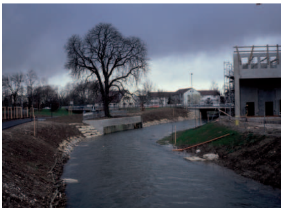
Abb. 3.19: Krainerwand und begrünte Steinschüttung (linkes Ufer) und Weidenfaschinen (rechtes Ufer) nach Fertigstellung
