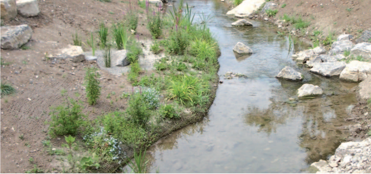
Abb. 4.36: Vegetationswalze (Rankbach bei Renningen)
