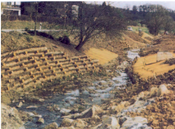
Abb. 3.15: Krainerwand nach Fertigstellung
