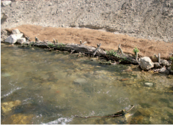
Abb. 2.16: Uferfaschine mit Naturfasertextil (Lauter in Kirchheim/Teck)
