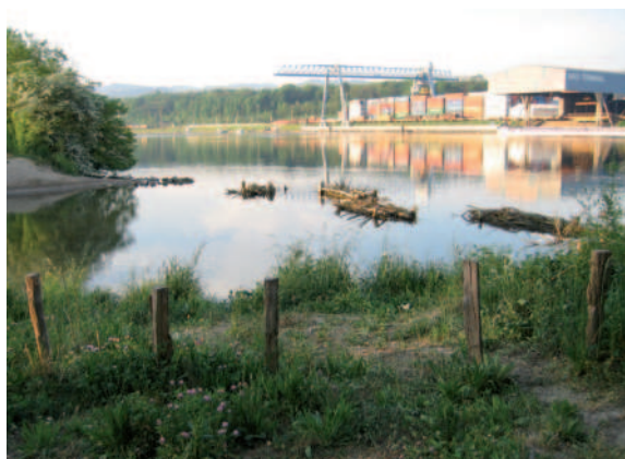
Abb. 4.43: Lahnung als Schutz vor Wellenschlag (Hochrhein/Grenzach-Wühen)
