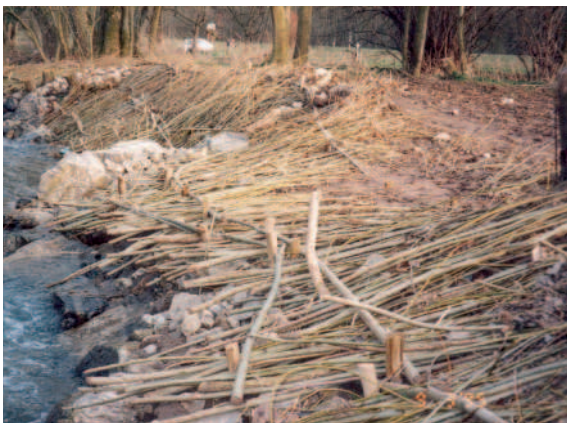
Abb. 4.10: Falscher Einbau: fehlende Einbindung der unteren Ästenden an der Uferlinie (Seitengerinne der Enz in Unterriexingen)
