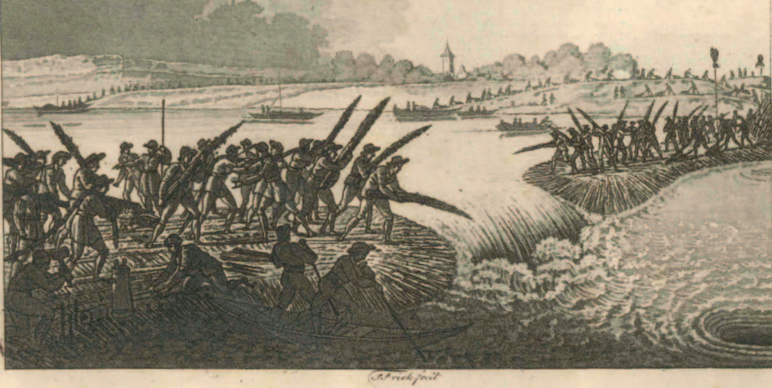
Faschinenbau bei einer Stromcoupirung
