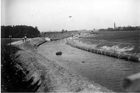
Abb. 2.4: Einbau von Faschinen an der Alten Rench, 1920
