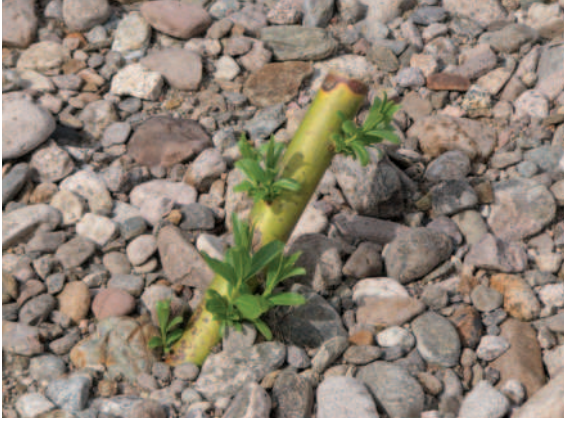
Abb. 4.24: Fachlich richtig eingebrachter Steckling
